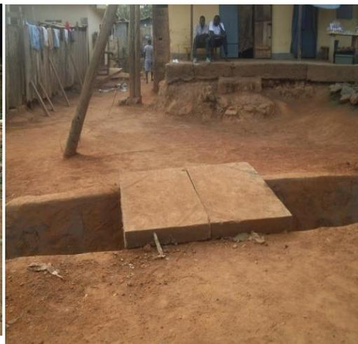
b) Ravin aménagé et praticable c) Passage en béton armé pour traversée
